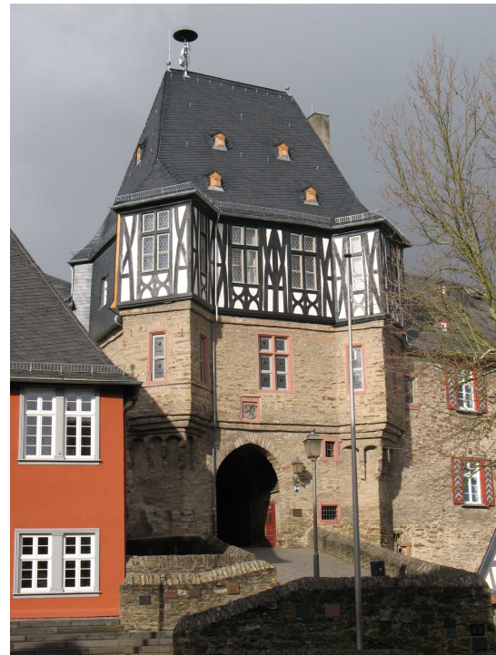
Das sanierte Kanzleitor
